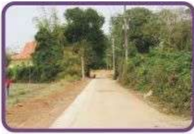
โครงการก่อสร้างรางระบายน้ำคอนกรีต เสริมเหล็ก ม.๑๐ สามแยกวัดร่องเคียว ถึงบ้านนายไพฑูย์ ดวงแก้ว
