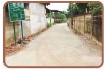
โครงการก่อสร้างถนนคอนกรีต เสริมเหล็ก หมู่ที่ ๑ บ้านนางสุข สิทธิปัญญา
