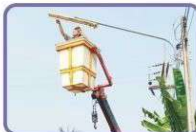
ซ่อมแซมไฟฟ้าแสงสว่าง
