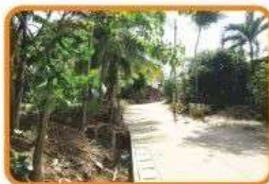
โครงการก่อสร้างรางระบายน้ำ คอนกรีตเสริมเหล็กซอยบ้าน นายมา แก้วโต ม.๕
