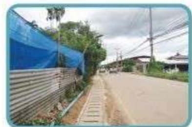
โครงการก่อสร้างรางระบายน้ำ คอนกรีตเสริมเหล็ก หมู่ที่ ๘ บ้านร่องยาง
