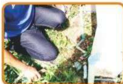
ซ่อมแซมประปา
