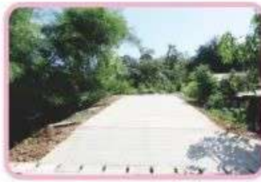
โครงการก่อสร้างถนนคอนกรีต เสริมเหล็กพร้อมรางระบายน้ำ สายบ้านนายปอน แสงจันทร์ ม.๒
