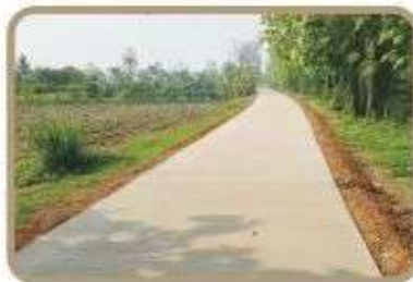
โครงการก่อสร้างถนน คสล. เลียบบคลองแม่พ่อง (ทิศตะวันออก) บ้านน้ำไสใต้ หมู่ที่ ๕
