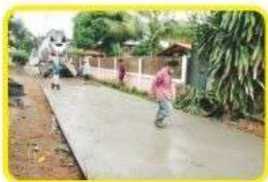
โครงการก่อสร้างถนน (คสล.) หมู่ที่ ๕ บ้านคุ้ม
