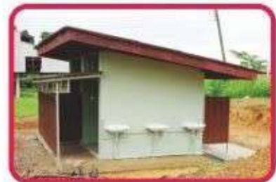
โครงการปรับปรุง ต่อเติม ห้องน้ำสาธารณะประจำสนามกีฬา หมู่ที่ ๑ บ้านน้ำไส
