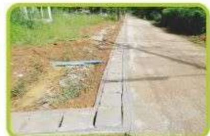
โครงการก่อสร้างรางระบายน้ำ คอนกรีตเสริมเหล็กซอยบ้าน นายบัว อินเขียว หมู่ที่ ๘ บ้านห้วยมุ่น
